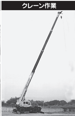
クレーン作業
