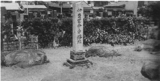
伊豆国分寺の塔跡（国指定史跡）
