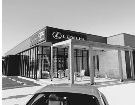
施工 加和太建設
