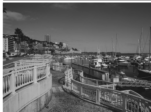
第2工区付近、現在第4工区の工事が進められている。
