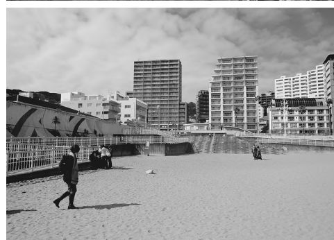
熱海サンビーチの養浜の施工状況と現在の状況
