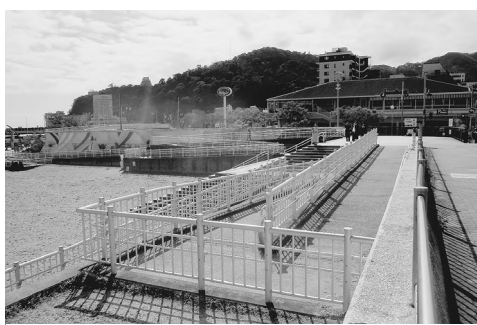
消波ブロックに覆われた海岸と現在の状況
