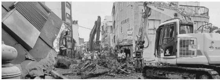
土砂撤去に活躍する地元建設業者
