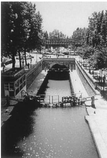
サン・マルタン運河の閘門（幅が狭いため当初は飲料水用だったが、今はレジャー用になっている）
