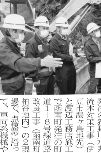
巡回したのは、土屋建設施工で沼津河川国道事務所発注の狩野川水系流木対策工事(伊豆市湯ケ島地先)と渡辺工務店施工で函南町発注の町道1-6号線道路改良工事(函南町柏谷地内)の2現場で、点検等に沿って、車両系機械や
