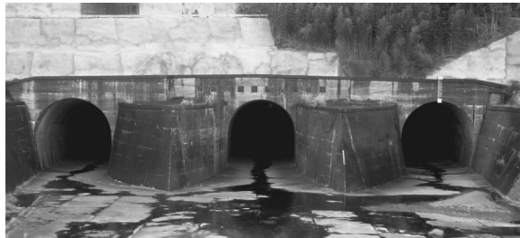
狩野川放水路の長岡トンネル。トンネルの大きさは3階建ての校舎とほぼ同じ
