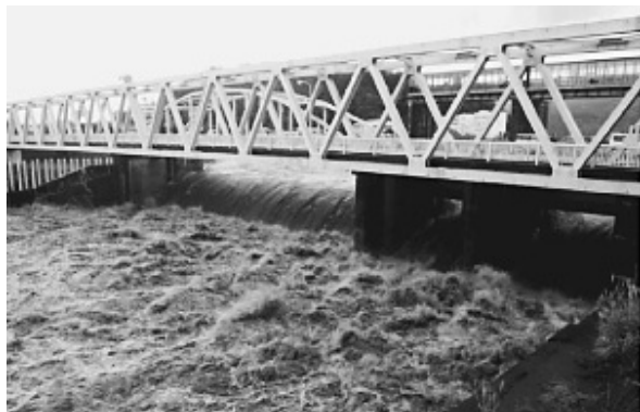
狩野川放水路放流状況（H28.5 台風10号）
