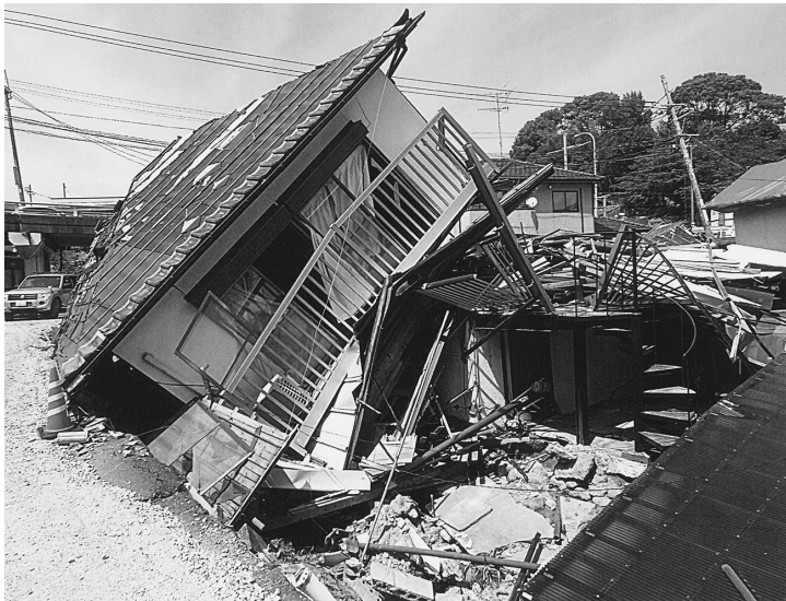
熊本地震における住宅被害
