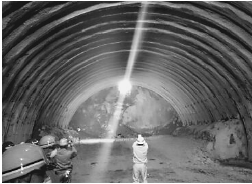
（仮称）下船原トンネル貫通の瞬間
