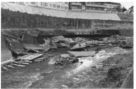
平成19年度大場川災害復旧工事
