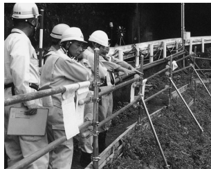
伊東市川奈地区の建設現場
