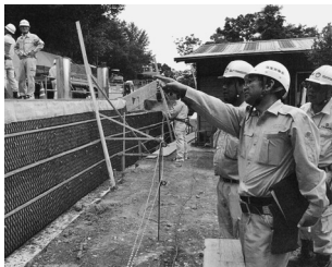
伊豆市下田地区の建設現場
