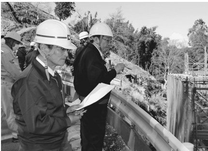
工する「平成26年度天城北 道路梶山高架橋下部工事」 （国土交通省沼津河川国道 事務所発注）と、三島市一 番町の加和太建設（株）が施 する「ホテル昭明館解体工 事」（株昭明館発注） の2現場で、各現場 では点検票に沿って 車両系機械や足場、 就労管理、届け出関 係などの項目につい てチェックしていた。
