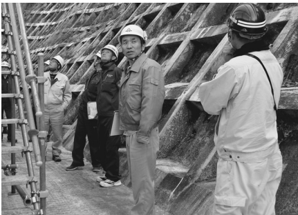
1カ所目は熱海市和田町 地内の川口組が施工する 「平成27年度「第27」S7 311-01号」八幡山県 単砂防等維持修繕工事（落
